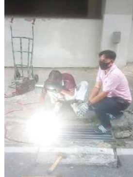
การปรับปรุง ซ่อมแซมฝาท่อระบายน้ำที่ชำรุด
