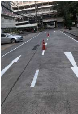
การตีเส้นจราจรเพื่อปรับเปลี่ยนเส้นทางจราจร
