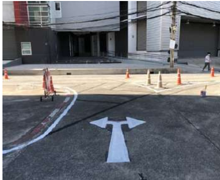
การตีเส้นจราจรเพื่อปรับเปลี่ยนเส้นทางจราจร
